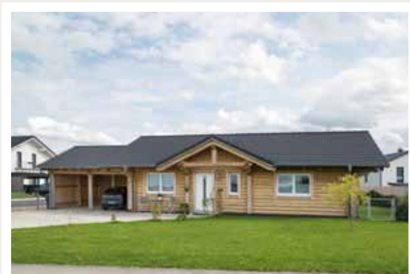
Fassade und Garage gehen fließend ineinander über. Die Fenster harmonisieren mit den Hausproportionen.
