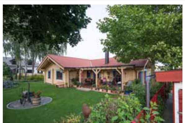
Hier ist der gesamte Terrassenwinkel überdacht und mit Säulen abgestützt.
