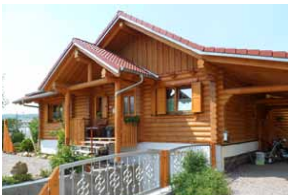
Dieses Haus steht am Hang, Carport und Garten befinden sich auf verschiedenen Ebenen.
