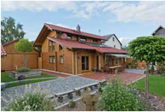
Die markante Dachlandschaft bietet von allen Seiten interessante Ansichten.
