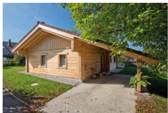
Das Schleppdach über dem Hauseingang ist gleichzeitig Carport.
