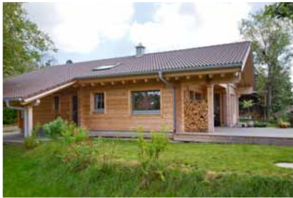
Die Holzsäulen von Carport und Terrasse passen perfekt zur massiven Kantholzbalkenkonstruktion.
